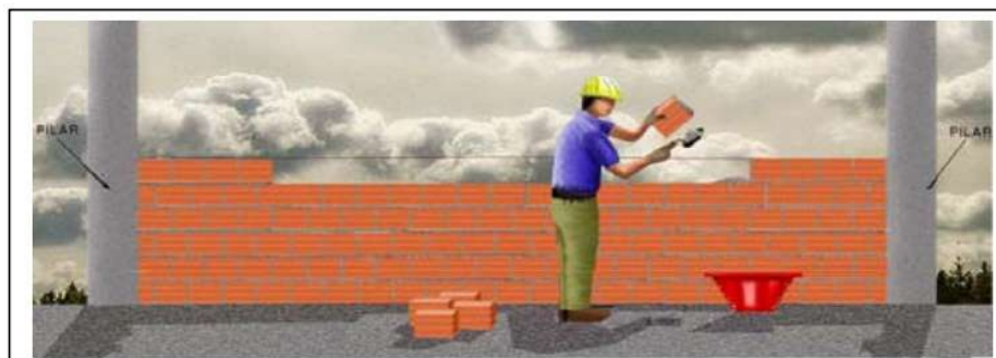
Assentamento de alvenaria 2
