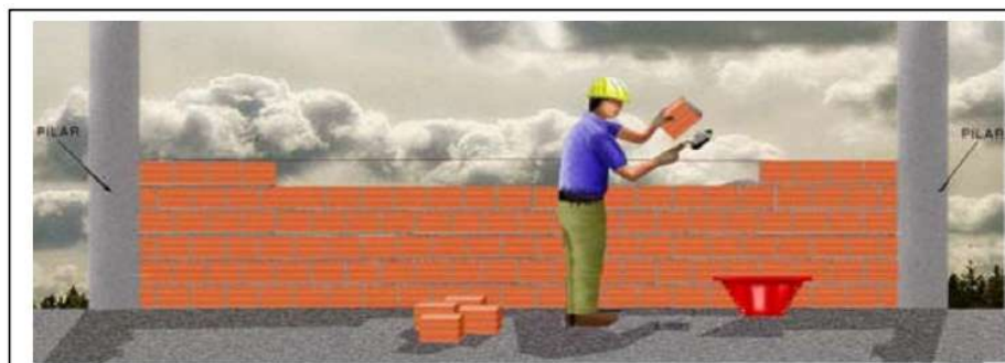
Assentamento de alvenaria 2
