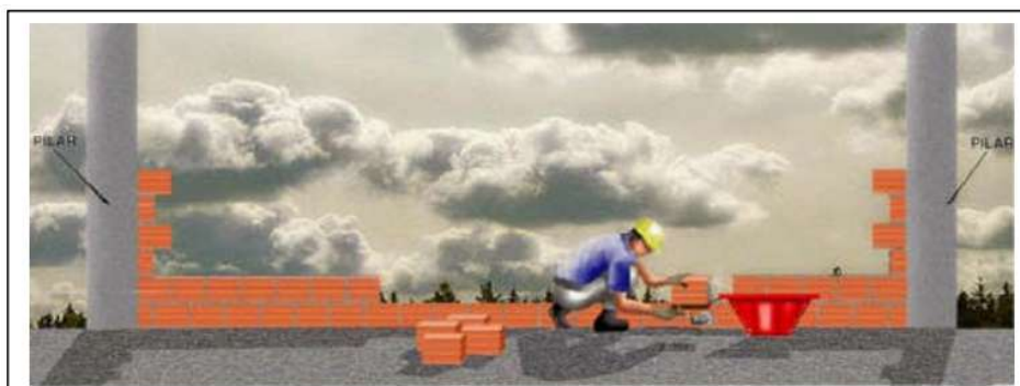
Assentamento de alvenaria 1
