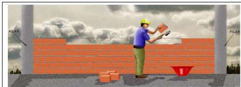
Assentamento de alvenaria 2
