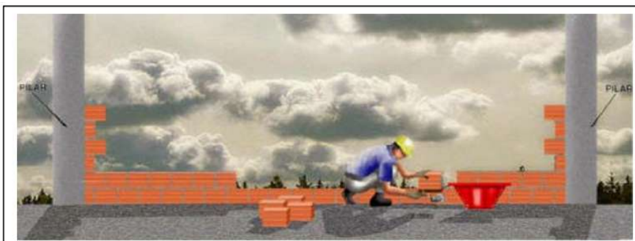
Assentamento de alvenaria 1
